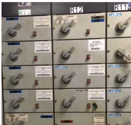
Exemplo de código de cores num quadro elétrico
